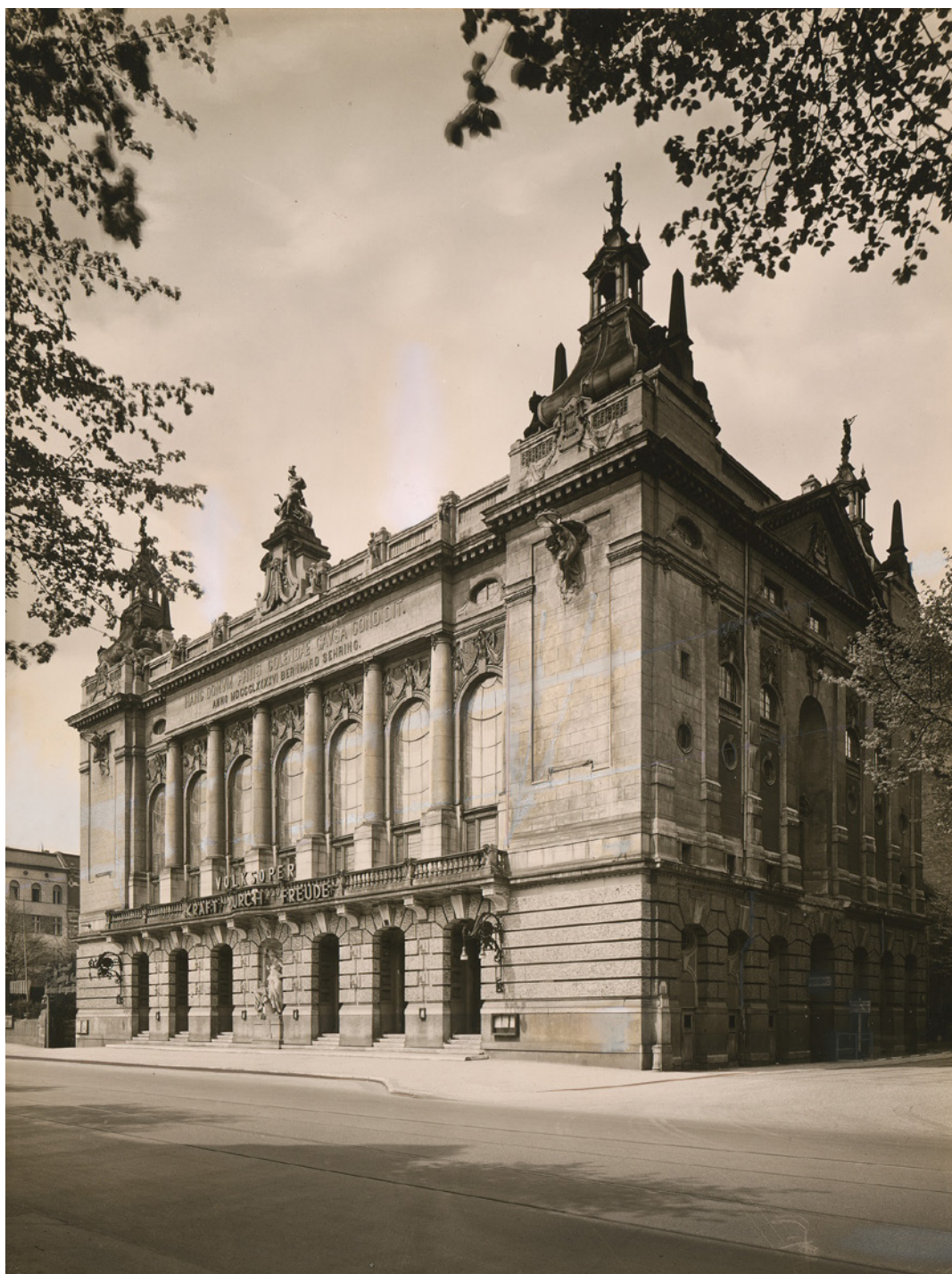
Bernhard Sehring (1855-1941, als Architekt / as an architect) + Max Missmann (1874-1945, als Fotograf / as photographer) Theater des Westens (auch / also: Volksoper), Berlin-Charlottenburg: Ansicht von Süden / View from the south Foto mit Retusche auf Papier über Karton / Photo with retouching on paper over cardboard 28,4 x 22,6 cm TU Berlin Architekturmuseum, Inv. Nr. TBS 046,10 https://architekturmuseum.ub.tu-berlin.de/index.php?p=79&POS=14
